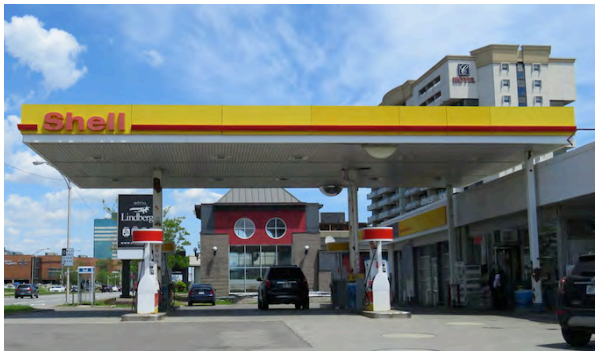
Marquise au-dessus des pompes à essence.
